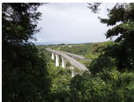
関越自動車道
