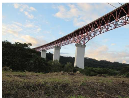
関越自動車道
