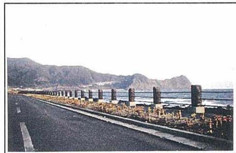
▲防護柵の代わりに玉石積の植栽帯 ▲地場産の石を素材にした防護柵
