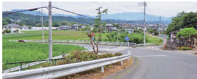
伐採により見通しが改善
