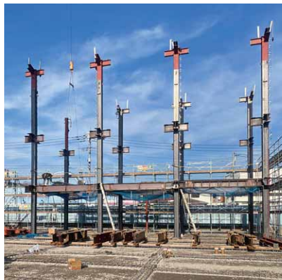
▼鉄骨組み立て(建て方)を開始。
