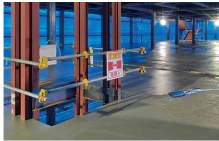
▲2階床のコンクリート打設。
