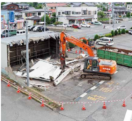
▲工事に支障となるバス車庫と玄関の一部を解体しました。
