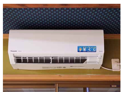
新たにエアコンを設置
