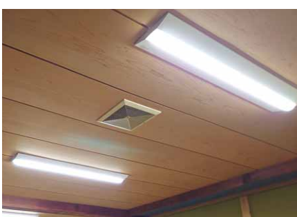
照明器具も交換
