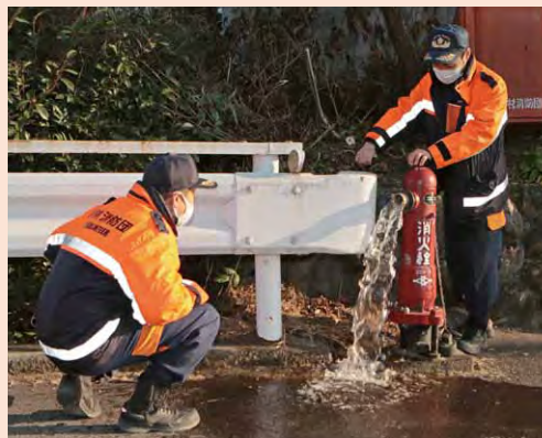
消防水利(消火栓)の点検
