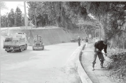
村内各地で行われた道路愛護運動
