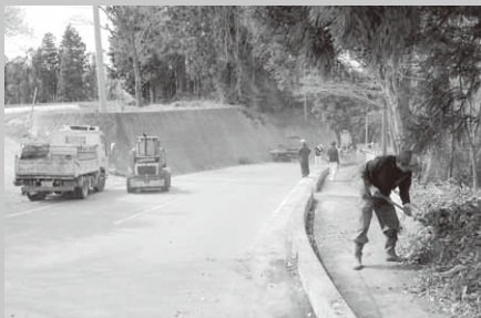
村内各地で行われた道路愛護運動
