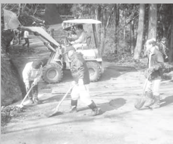
村内各地で行われた道路愛護運動
