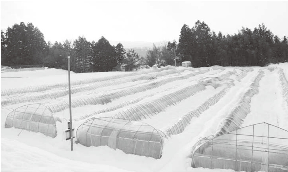
積雪により倒壊したビニールハウス
