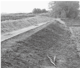
法面の損壊がないように草刈りによる除草を!!
