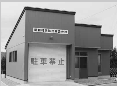
完成した第2分団の詰所
