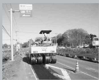
舗装工事が行われた永井中野線
