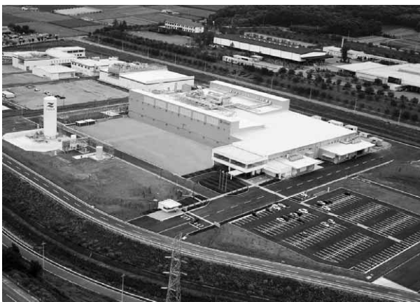
天然ガス貯蔵タンク（写真左）がシンボルの昭和事業所
