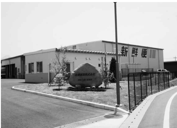
関屋工業団地に完成した佐藤運送(株)昭和インター営業所
