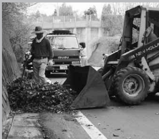
トンネル付近の作業の様子
