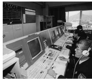
消防本部の通信司令室
