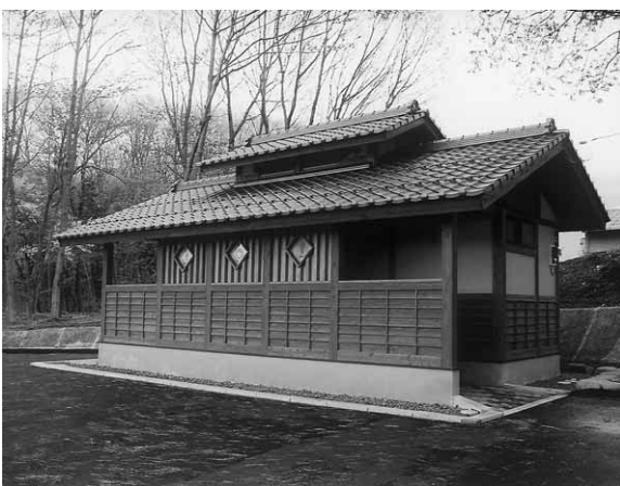
完成した公衆トイレ
