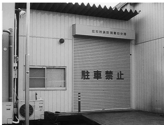
改築された第8分団の詰所
