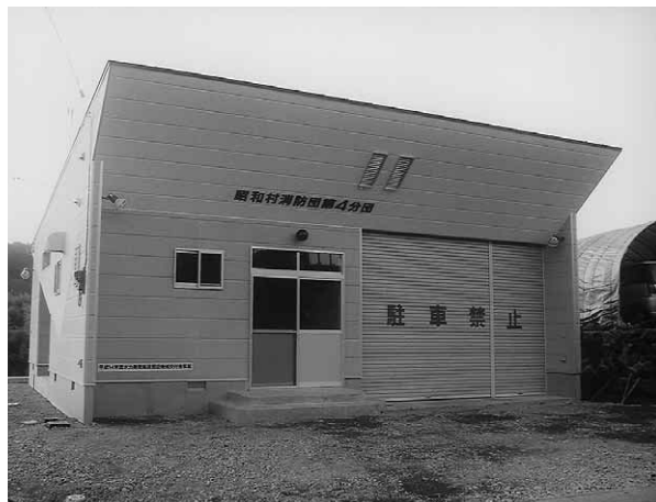
完成した第4分団の詰所
